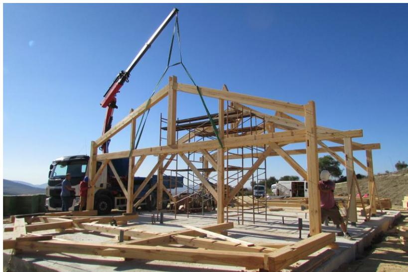
Figure 9. Apprentissage de la menuiserie de structures en bois sur le chantier. Auteur : Loris Carboni
